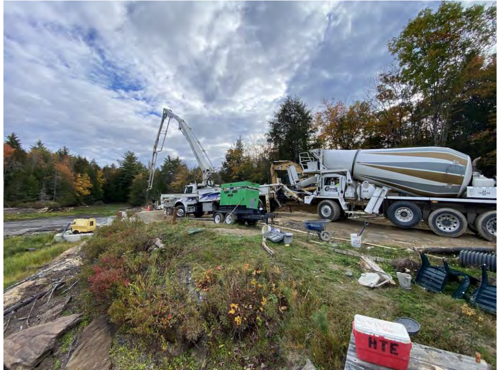
Knife wall pouring
